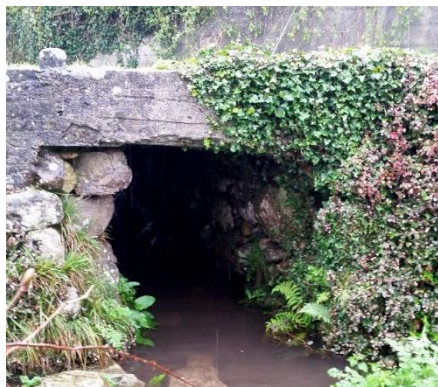
Fig. 12. Vista da Ponte do Rial
