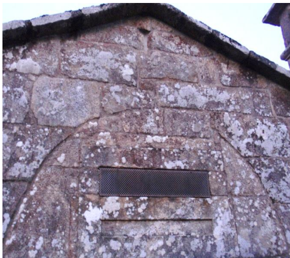
Fig. 31. Detalle das modificacións da estrutura da capela. Fotografía tomada polo autor en agosto de 2018.
