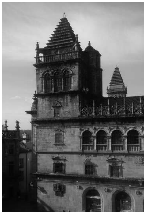
Torre del Tesoro
