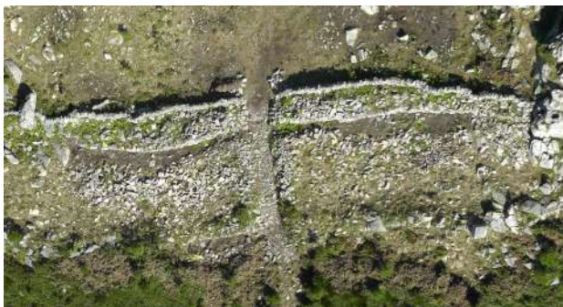
Figura 11- Fotografía aérea do sector oeste da muralla. Foto: Equipo Torre dos Mouros
