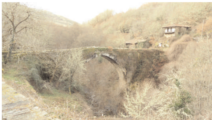
Ponte sobre o Navea. Foto Miguel Losada (SAGA) 2014
