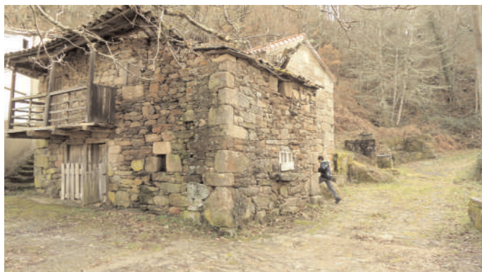
Casas da Ponte Navea, ó pe do camiño. Foto Miguel Losada (SAGA) 2014
