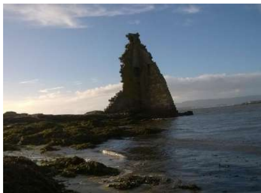
Ruínas da Torre de San Sadurniño. (Fotografía do autor.)
